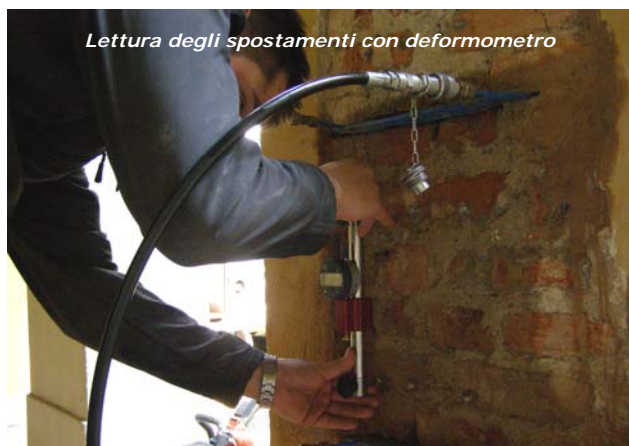
Esecuzione di prova con martinetto singolo
